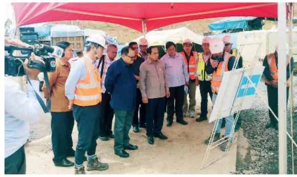
ທ່ານ ປອ ບຸນທອງ ຈິດມະນີ ຮອງນາຍົກລັດຖະມົນຕີ, ປະທານຄະນະກວດກາສູນກາງພັກ, ປະທານອົງ ການກວດກາລັດຖະບານ ແລະ ຫົວໜ້າອົງການຕ້ານ ການສໍ້ລາດບັງຫລວງຂັ້ນສູນກາງ ລົງຕິດຕາມຄວາມ ຄືບໜ້າການກໍ່ສ້າງຄູກັ້ນນ້ຳ D ໂຄງການໄຟຟ້າເຊ ປຽນ-ເຊນ້ຳນ້ອຍ (04/10/2019)
